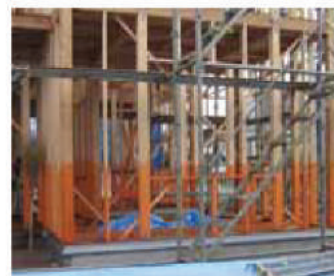
写真1 新築住宅防蟻処理
